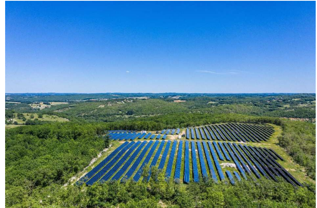
Centrale de Salviac (46) Localisation : Salviac (Lot) Surface totale : 11 ha Puissance : 4,5MWc En service : décembre 2017 Activité agricole : exploitation ovine
