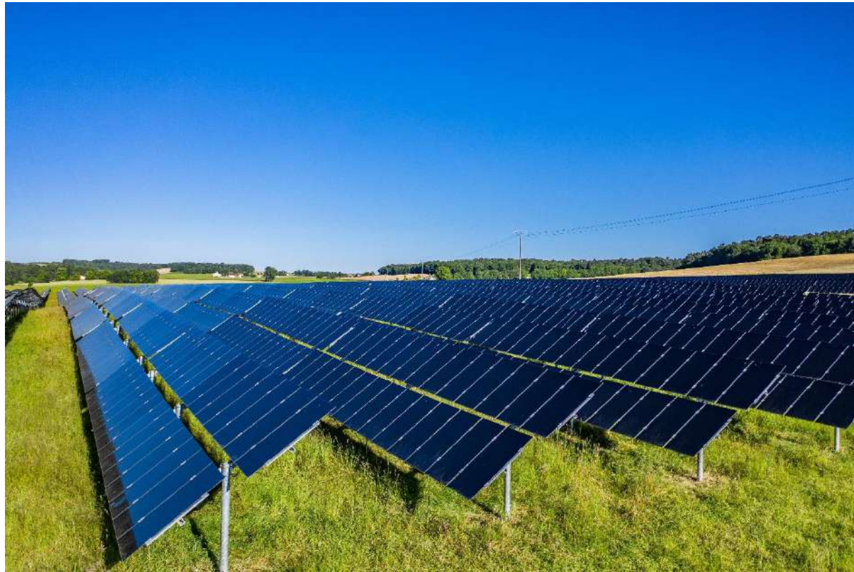
Centrale de Saint-Martial (16) Localisation : Saint-Martial (Charente) Surface totale : 16 ha Puissance : 8MWc En service : août 2015 Activité agricole : exploitation ovine
