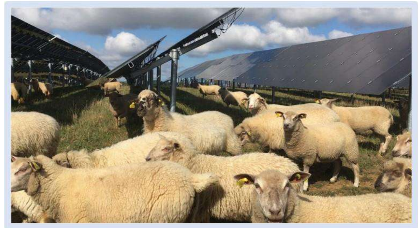
Figure 50 : Synergie agrivoltaïque sur la centrale de Saint-Martial (16)
