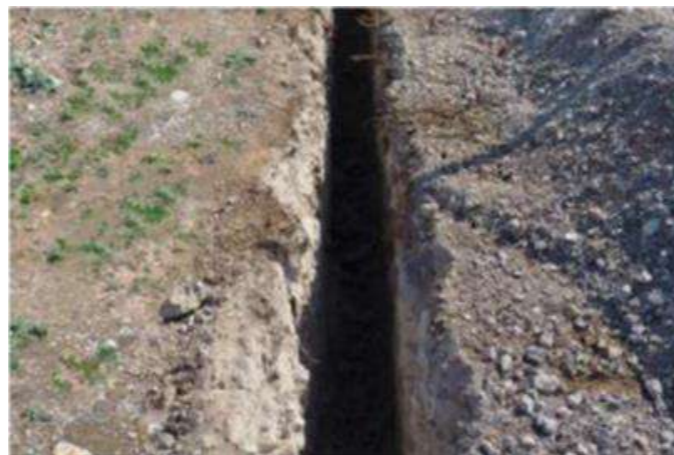
Figure 56 : Tranchées pour les gaines électriques
